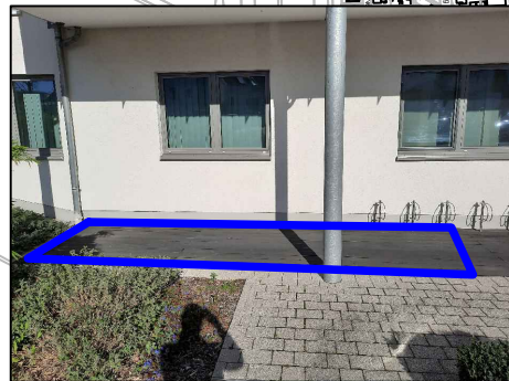
Standort 8: Baugenossenschaft / Mozartstr. 15
